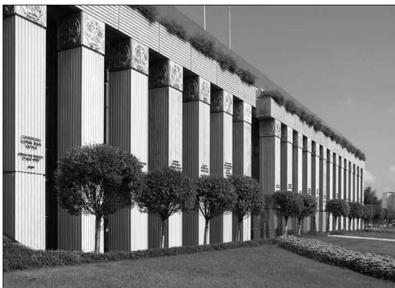
Budynek Sądu Najwyższego w Warszawie. Źródło: www.wikipedia.org
