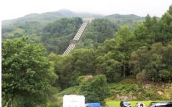
Fot. 02. Rurociąg doprowadzający wodę do turbin elektrowni wodnej Loch Sloy w Szkocji, położonej nad jeziorem Loch Lomond. Zainstalowana moc: 152,5 MW.
