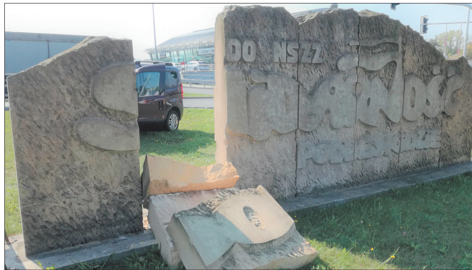
Obelisk na Rondzie „Solidarności” tuż po uszkodzeniu – wrzesień 2018 roku.
